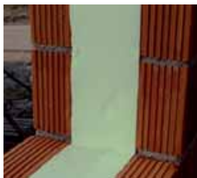
Ostenie a parapet vyplnené extrudovaným polystyrénom
