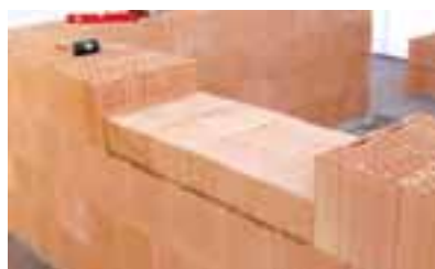
Parapet vytvorený z tehál K1/2
