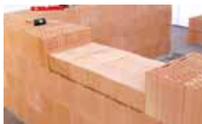
Parapet vytvorený z tehál K1/2
