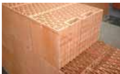
Založenie ostenia okenného otvoru z tehál K
