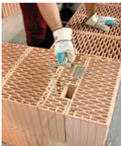
Kapsy na koncovej polovičke sa vyplnia tepelnoizolačnou maltou.
