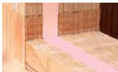
Detail hotového ostenia a parapetu
