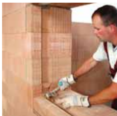
V ostení a parapete sa vyklepne krycie rebro príslušnej kapsy
