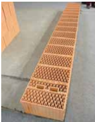
Založenie rohu pomocou rohovej tehly a koncovej polovičky. Na koncovej polovičke sa vyklepnú obe krycie rebrá.
